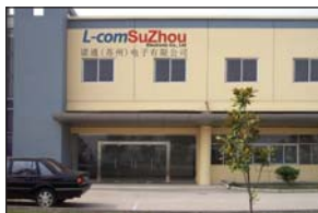
Fabrica de Manufacturacion y Envios en Asia, en Suzhou, Jiangsu, China 215021
