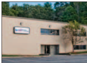
Planta de fabricación de conjuntos de cables, North Andover, MA 01845, EE.UU.
