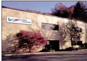
Edificio de Fabricacion de Ensamblaje de Cables, en North Andover, MA 01845, EUA
